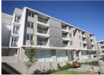
Condominio Alto La Reina Línea Advance SS85, SS62 Constructora Sigma
