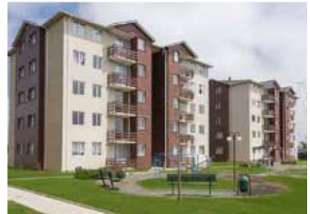
Casas Hualpén Color blanco / Concepción Constructora GPR
