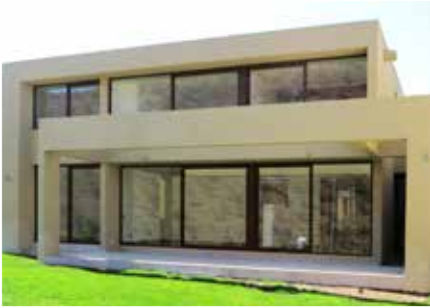
Proyecto Canquen 4 Línea Aspen SS74, C60 Constructora SAE
