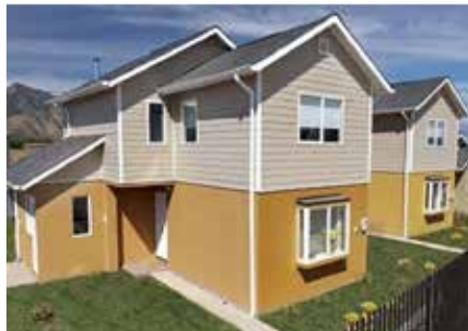
Casas Buin Color blanco / Santiago Constructora GPR
