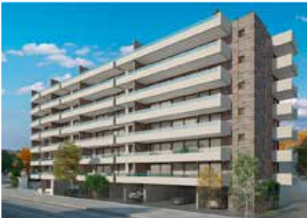
Mar Jónico Color nogal / Santiago Constructora ISA
